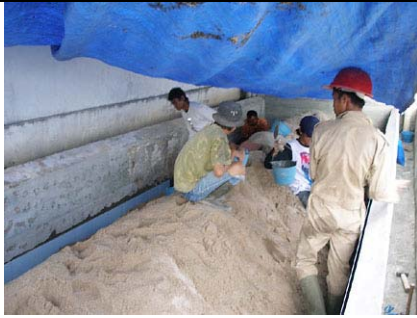
Banda Aceh - Reinigung Sandfilter der Wasser- aufbereitungsanlage
