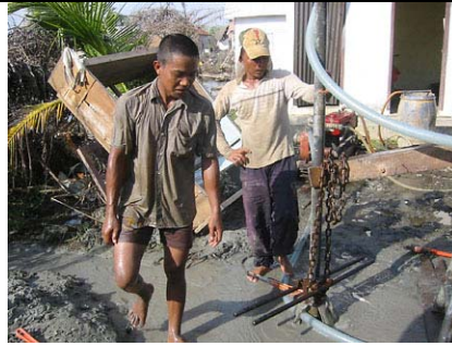
Bohrung eines neuen Brunnens in der Region Meulaboh
