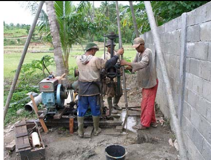
Seulimeum - Brunnenbohrung bei einer Schule
