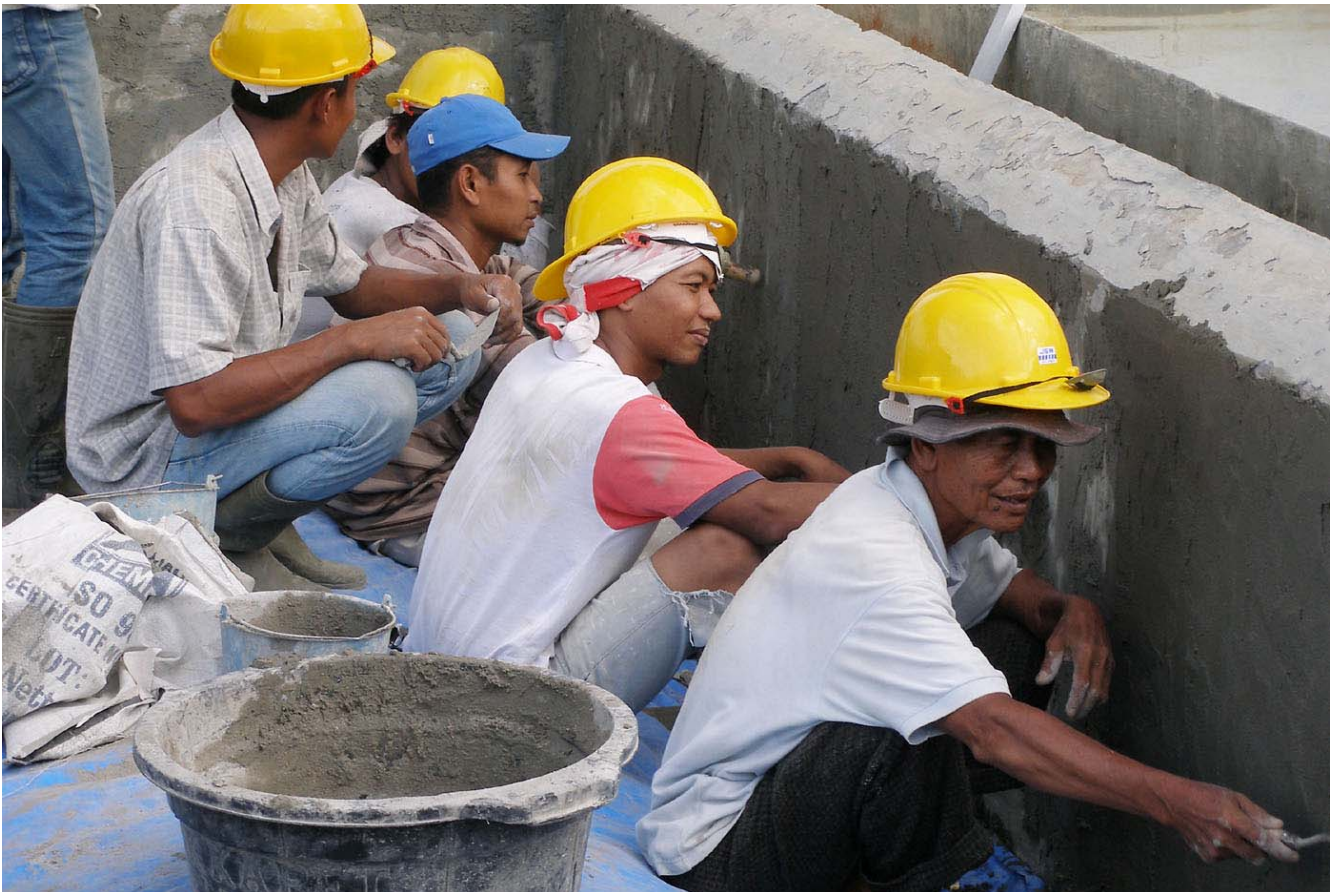
Sanierung der Wasseraufbereitungsanlage Lamabro, Aceh, Indonesien
