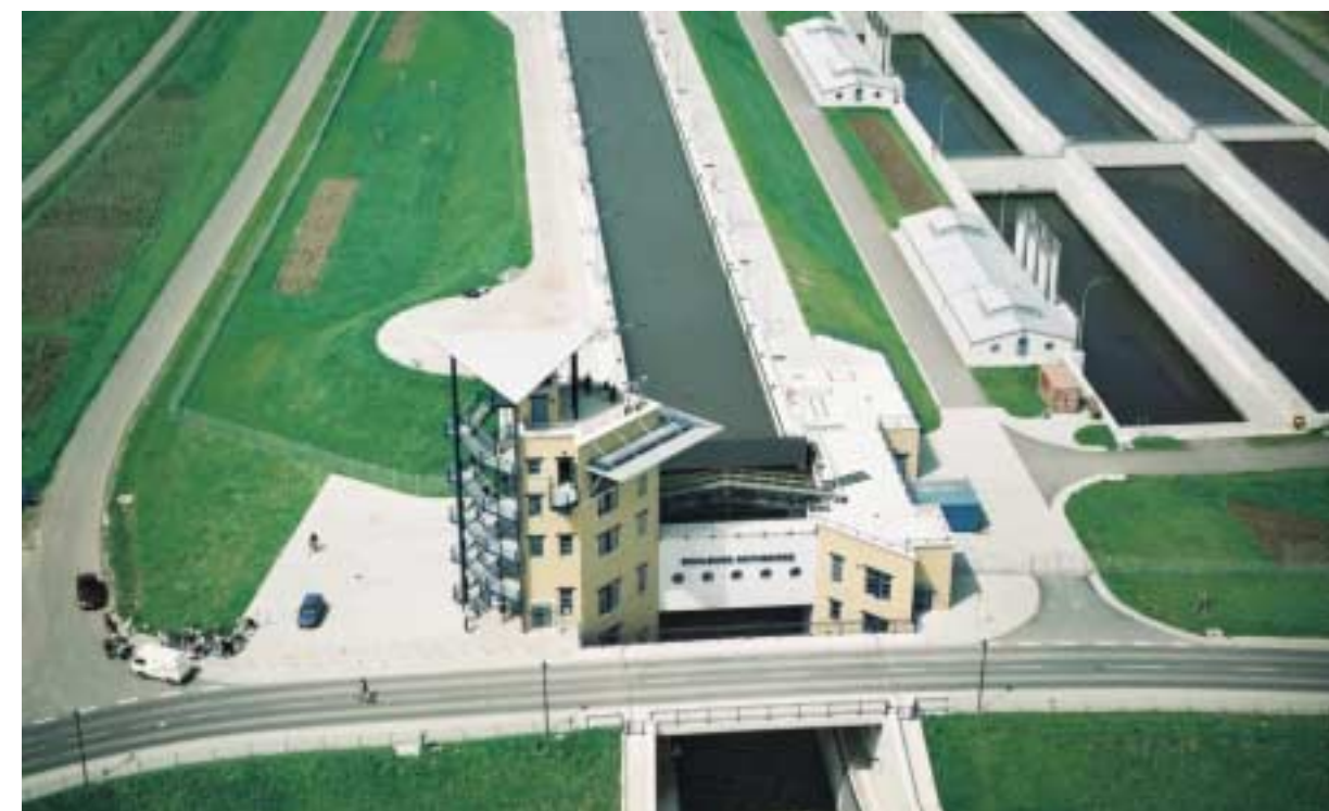
Sparschleuse Rothensee mit Steuerstand und Aussichtsplattform, Mai 2002
