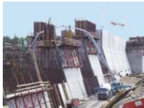
Betonieren der Kammerwände
