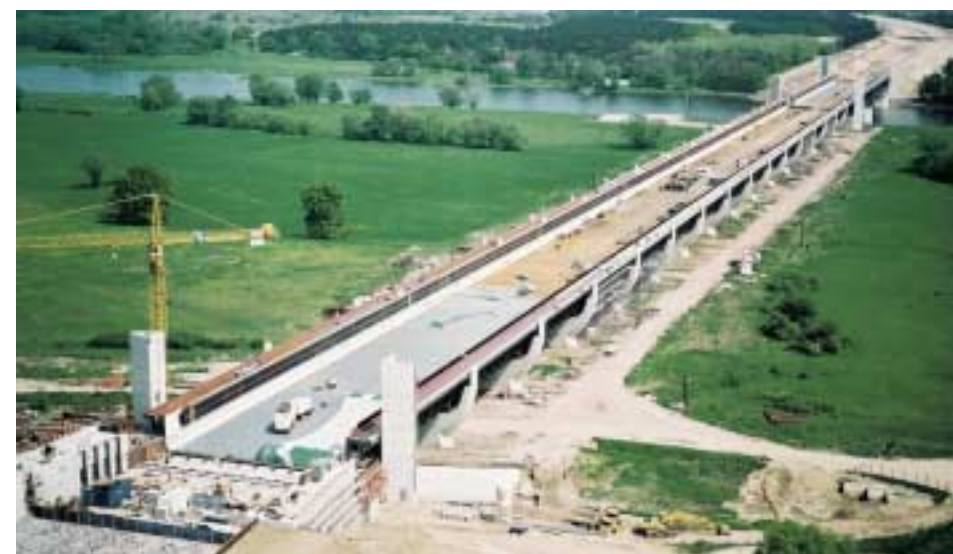
Baustelle Kanalbrücke bei Hohenwarthe, Mai 2002
