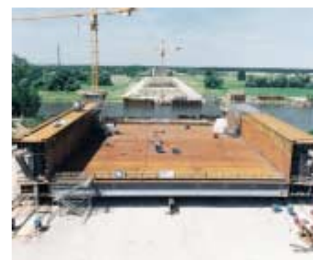
Montage Stahltrög, Juli 1999
