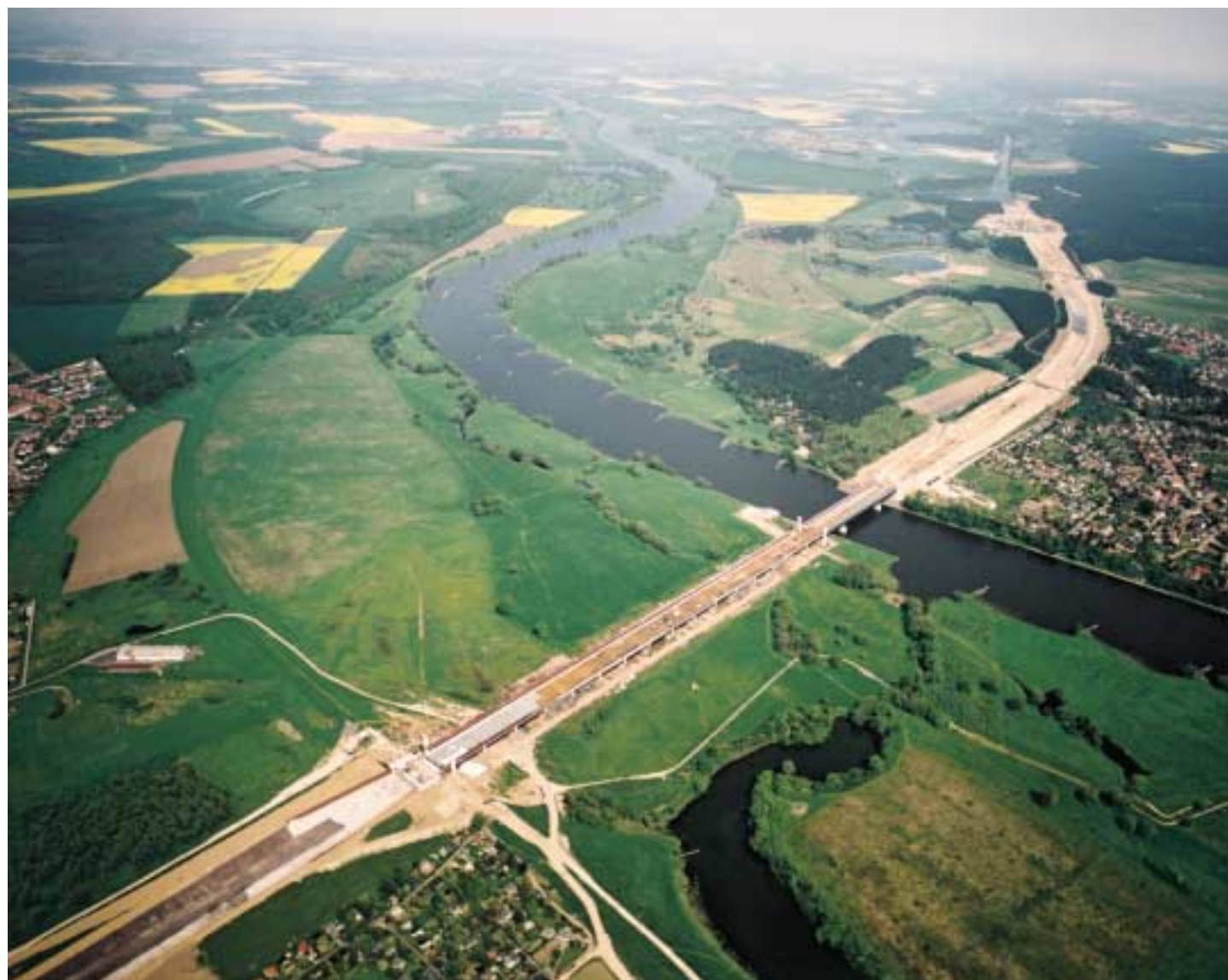
Baustelle Wasserstraßenkreuz Magdeburg mit Kanalbrücke über die Elbe, Mai 2002
