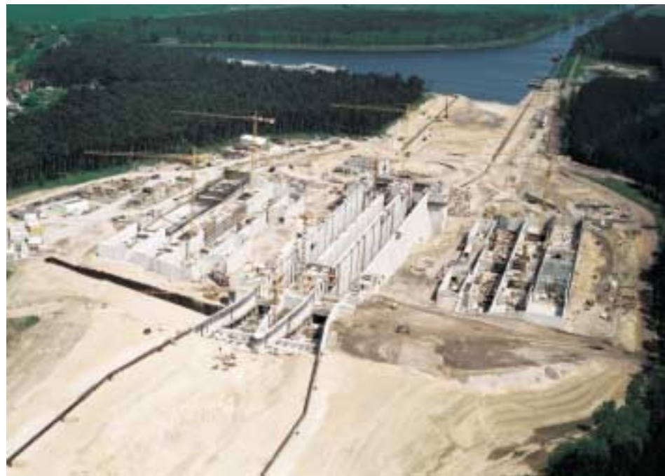
Bau der Doppelsparschleuse, Mai 2002
