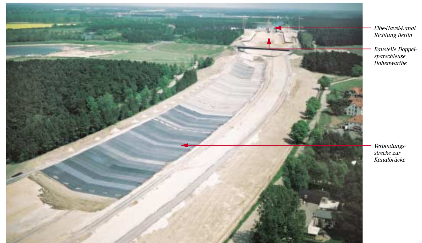
Bau des Anschlusskanalstrecke östlich der Kanalbrücke bei Hohenwarthe, Mai 2002
