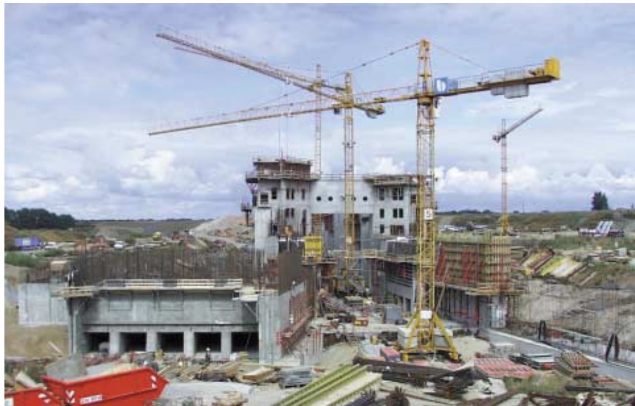
Unterhaupt mit Pumpwerk, August 1999
