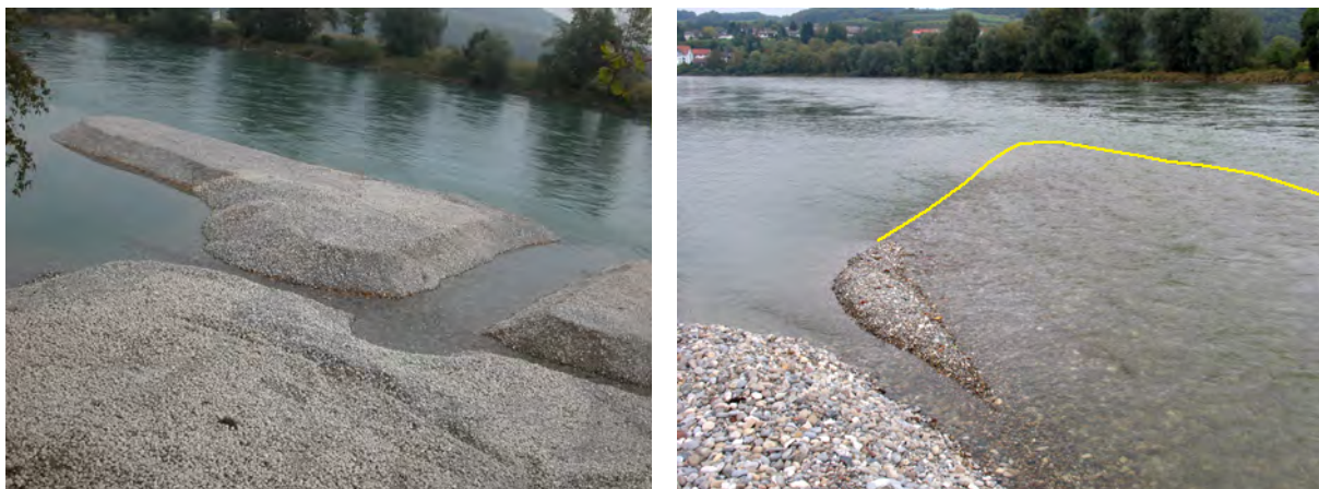
Bild 8.10 Kiesbank bei der Schüttstelle Zurzach unmittelbar nach dem Einbau (links) und 1 Woche später (rechts, Geschiebezone gelb umrandet). Abfluss = 450\text{m}^3/\text{s} .
