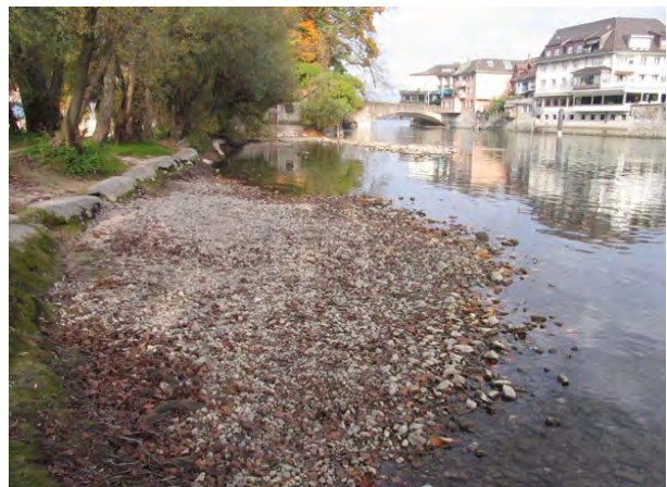
Bild 6.22 Geschiebeablagerungen im Strömungsschatten der Insel Rheinfeldern (km 149.1) nach dem Hochwasser vom August 2005 ( Q_{max} = 3'464m^3/s ).
