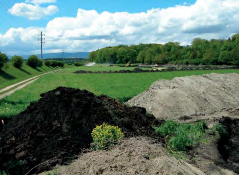
Bauarbeiten für ein neues Seitengewässer im Espenmoos
