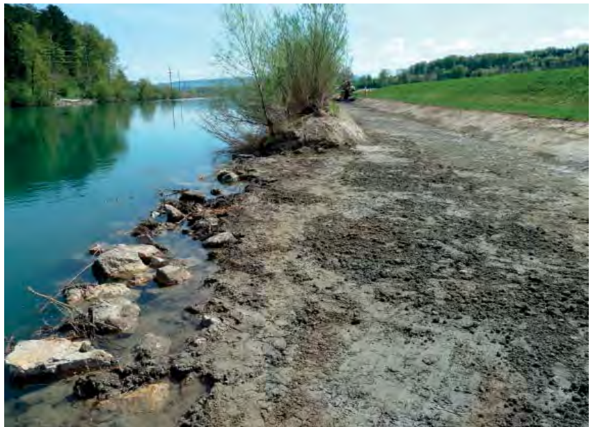
Ausgestaltung eines Flachufers für neue Riedwiesen am sanierten Hagneckkanal
