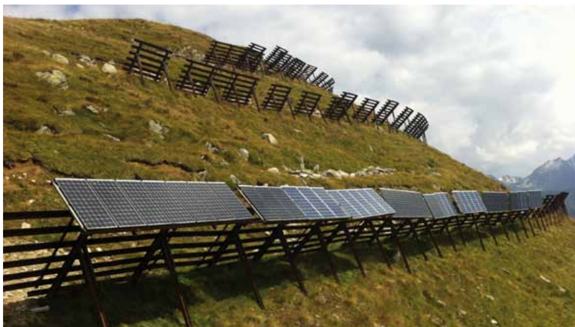
Abbildung 5.1: Pilotanlage Bellwald: Photovoltaikanlage an bestehenden Lawinverbauungen. Quelle: Enalpin AG.
